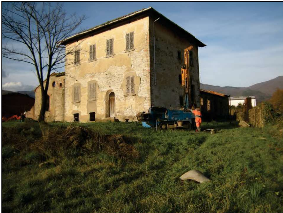
Fig. 2 - Sonda cingolata CMV durante l'esecuzione del sondaggio ambientale Pz4
